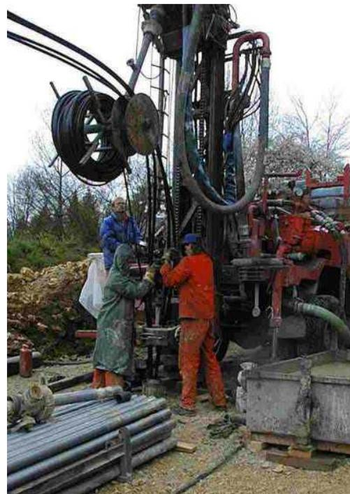
Bild 1.7 Einbau einer Erdwärmesonde (Foto: Grundag AG, Gossau).
