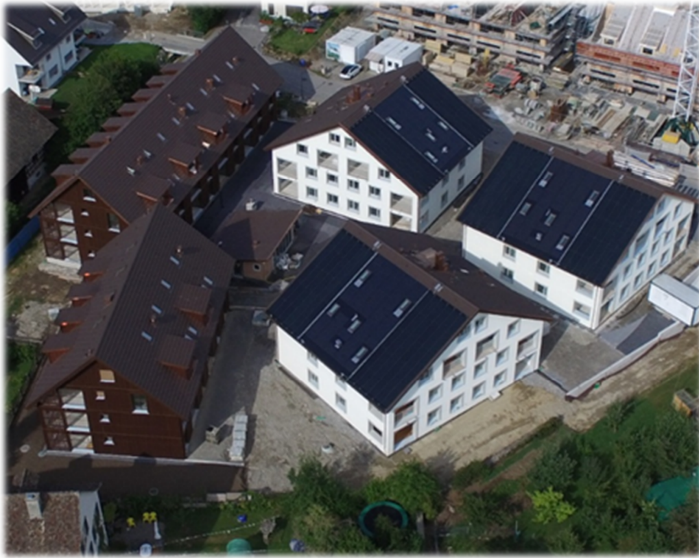
Wohnüberbauung Pfreundmatt, Mettmenstetten
